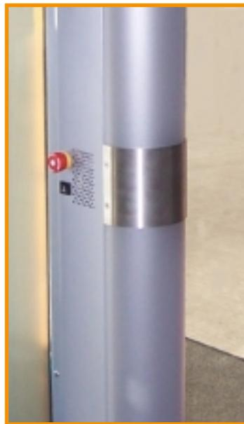
air-gate® fix ist so installiert, dass es automatisch anläuft, wenn sich die Tür öffnet und stoppt, wenn die Tür wieder schließt. Steht die Tür ständig auf, läuft air-gate® fix permanent.
